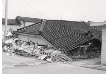
能登半島地震による住宅被害 (平成19年3月、三重県撮影)
